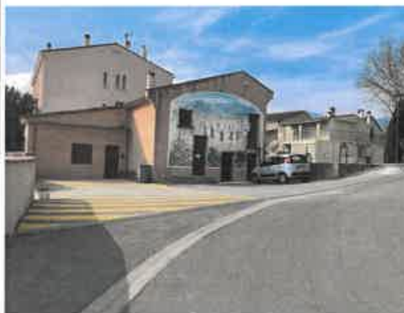
Local pour poste de police municipale
